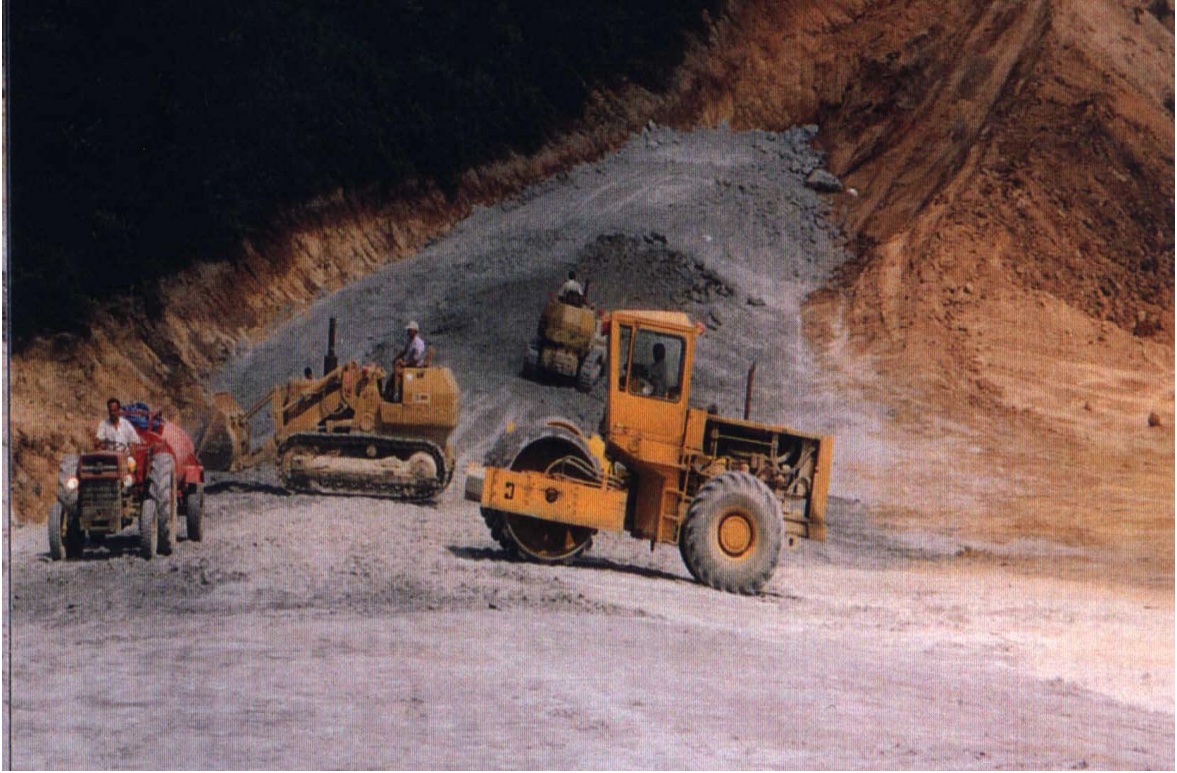
Şekil 5. 2000 yılı Odayeri depolama sahası depo son seddesi inşası.
