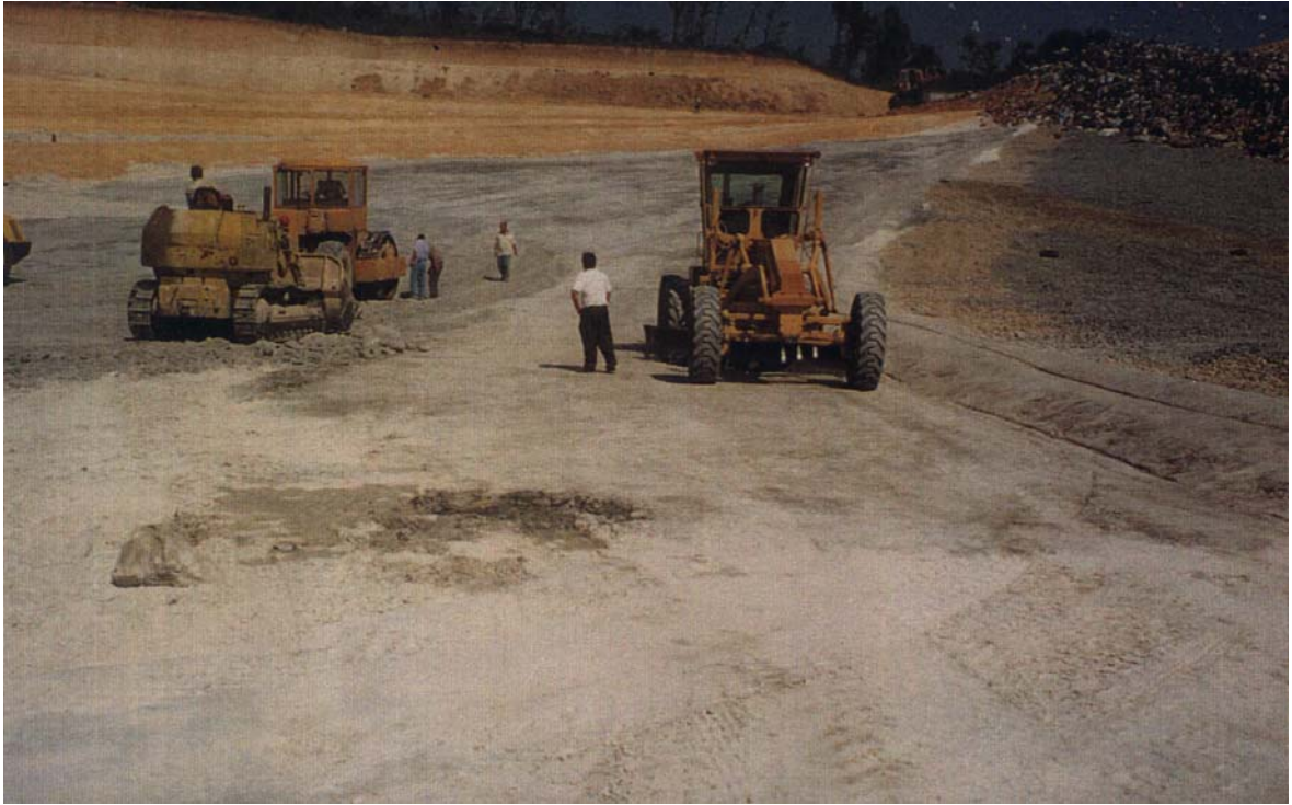
Şekil 4. 2000 yılı Odayeri depolama sahası geçirimsiz kil tabakası inşası.
